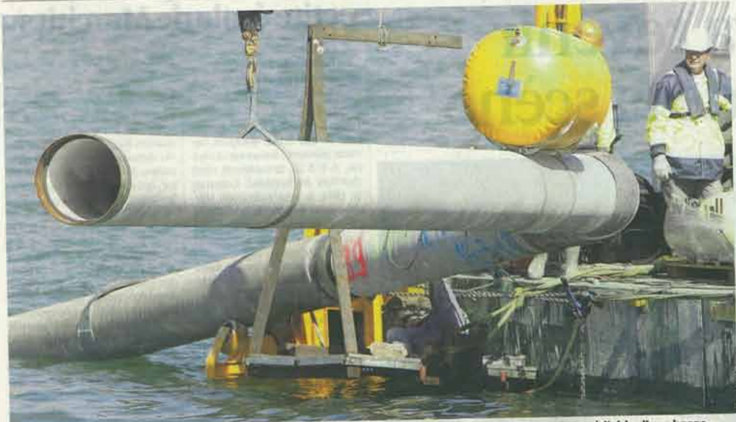
Acheminés jusqu'à l'endroit où ils seront immergés, les éléments sont soudés entre eux, hors de l'eau, à l'aide d'une barge.
